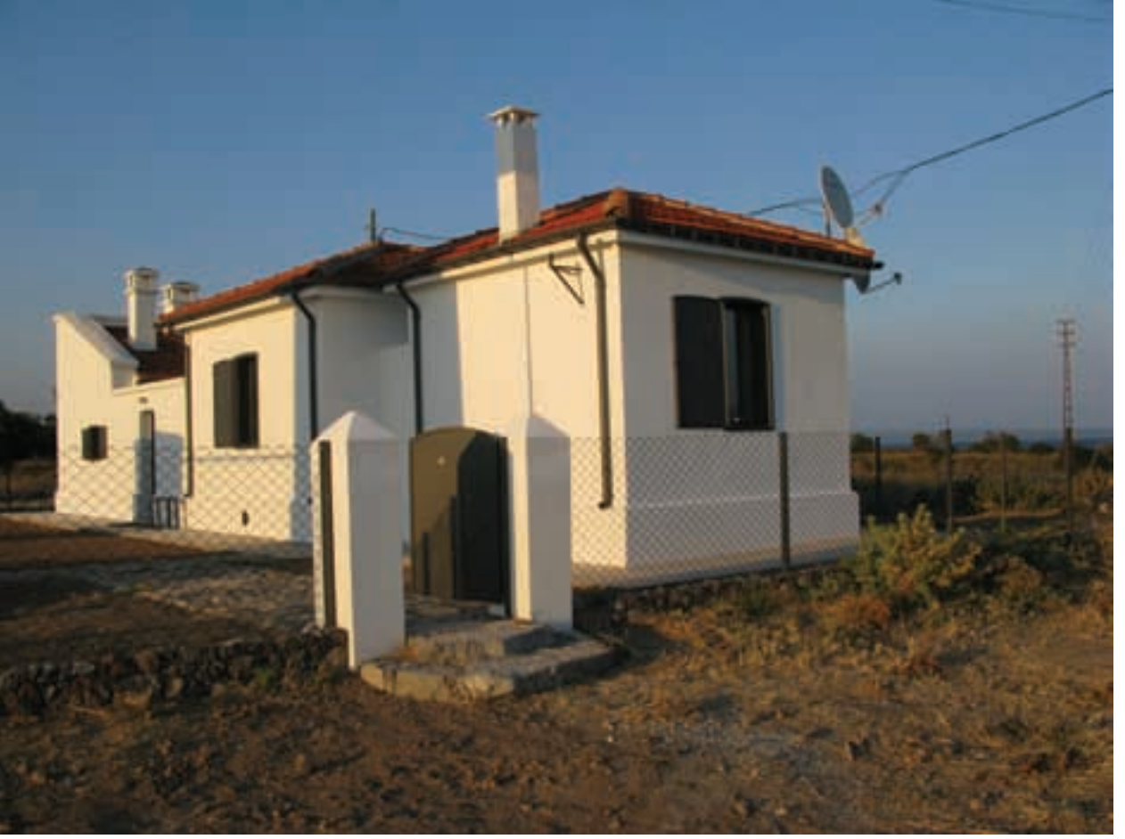
fotoğraf: M. Melih Güneş, onarım sonrası, 2009
