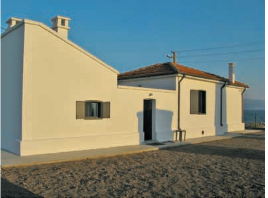
fotoğraf: M. Melih Güneş, onarım sonrası, 2009
