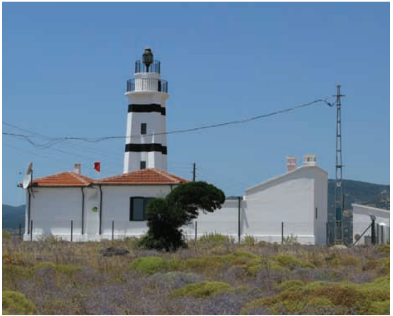
fotoğraf: M. Melih Güneş, onarım sonrası, 2009
