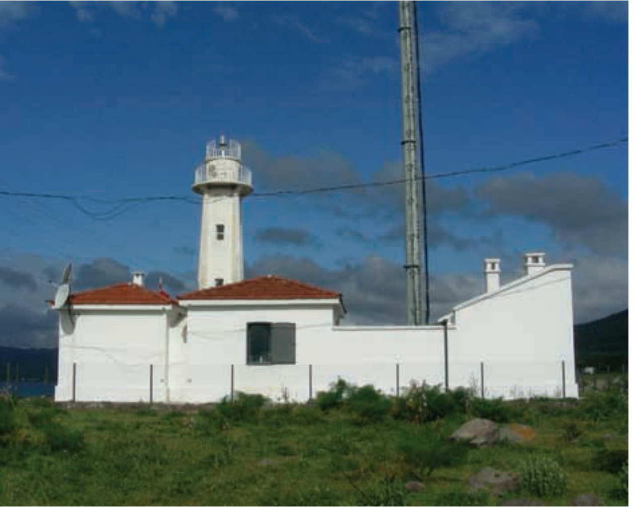
fotoğraf: M. Melih Güneş, onarım öncesi, 2009
