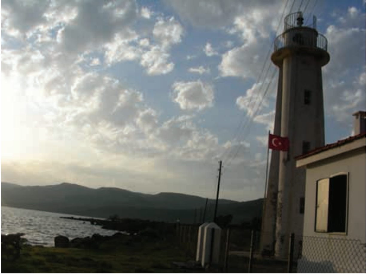
fotoğraf: M. Melih Güneş, onarım öncesi, 2009
